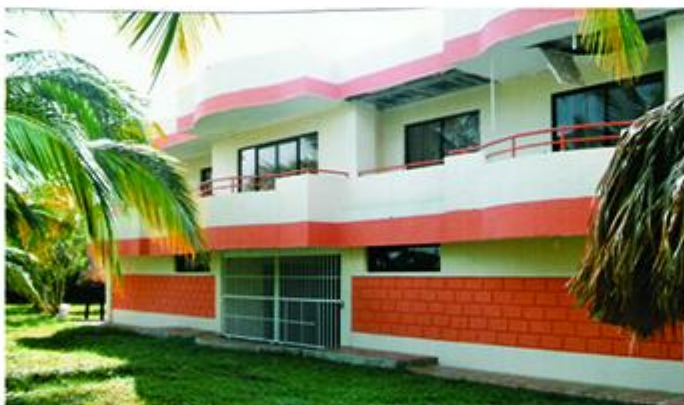
Vista posterior-exterior, del Centro Recreacional restaurado.
