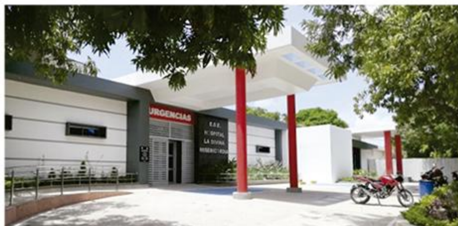
Nueva fachada de urgencia 2.019
