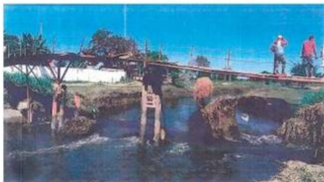
El destaralado puentecillo en la vía que conduce de Magangué a Madrid, la mano redentora del nuevo alcalde le está haciendo un reforzamiento.
