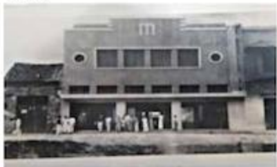
La veja casa modificada en el edificio de dos pisos, década de los años 50.
