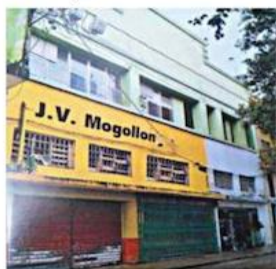
Fachada por la calle de las Flores.
