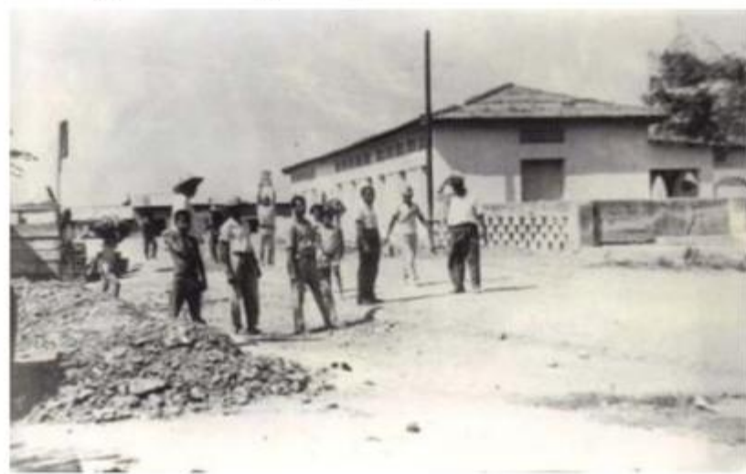
Pavimentación sector las Mojarritas
