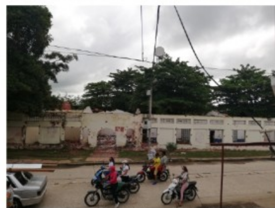
"Las Mojarritas" en estado de abandono
