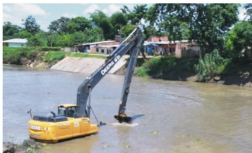
La máquina de Equitesa-Equitransa extrae los sedimentos acumulados en el lugar de la toma de agua para potabilizar y distribuir entre los habitantes de la ciudad de Chone.
